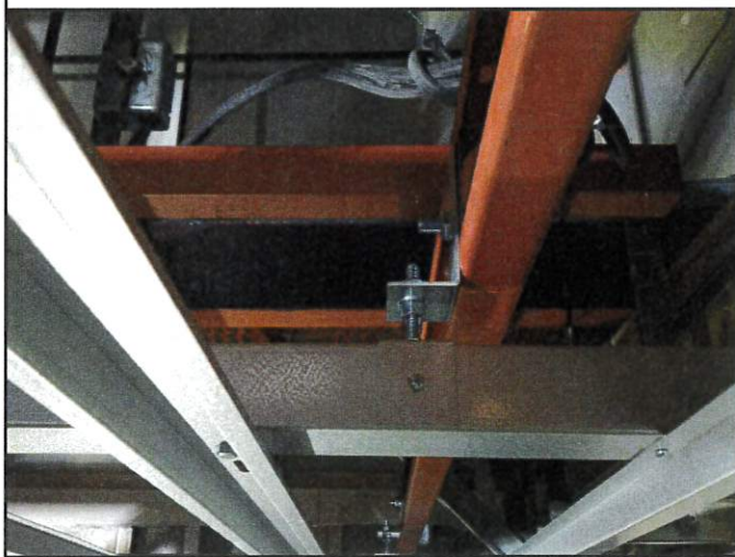
下地取付け元部分
