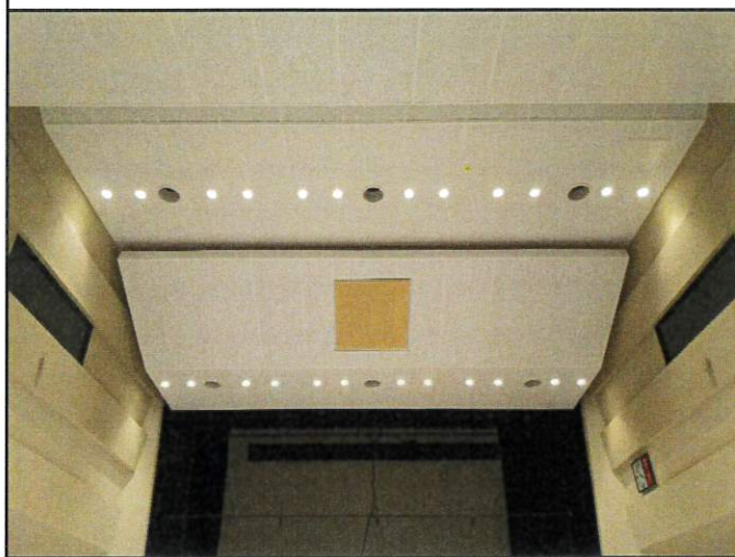
改修後天井全景
