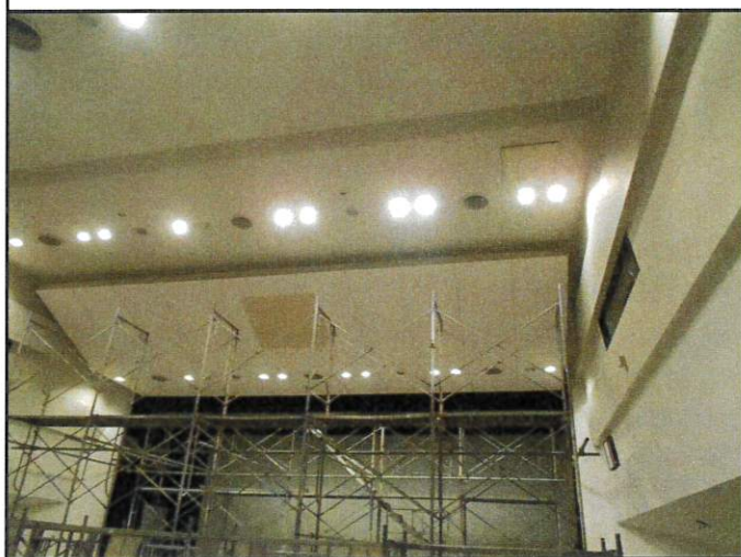
改修前天井全景
