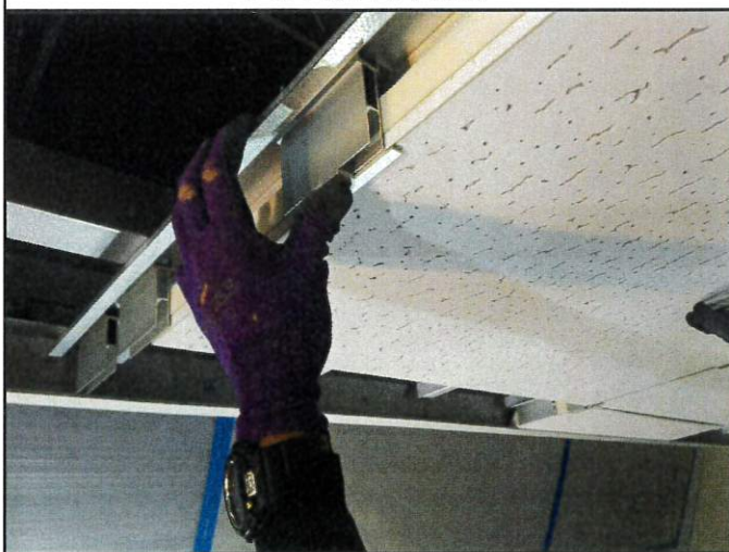
天井材挿入状況
