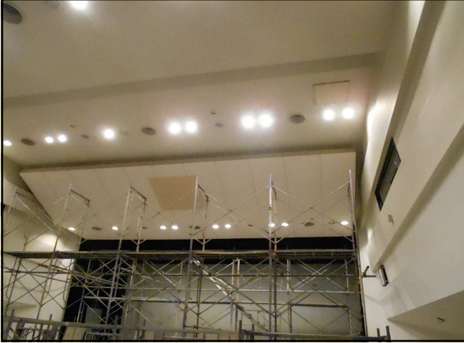
改修前天井全景
