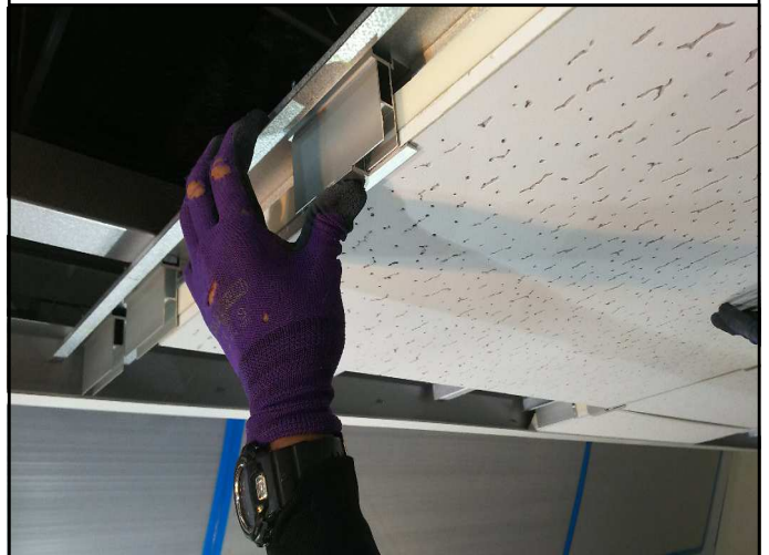
天井材挿入状況
