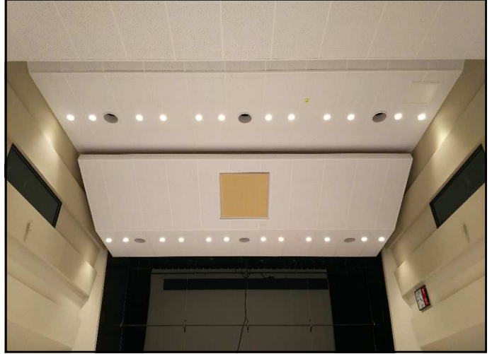
改修後天井全景
