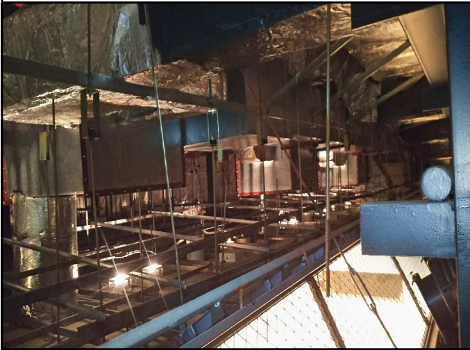
改修前天井裏
