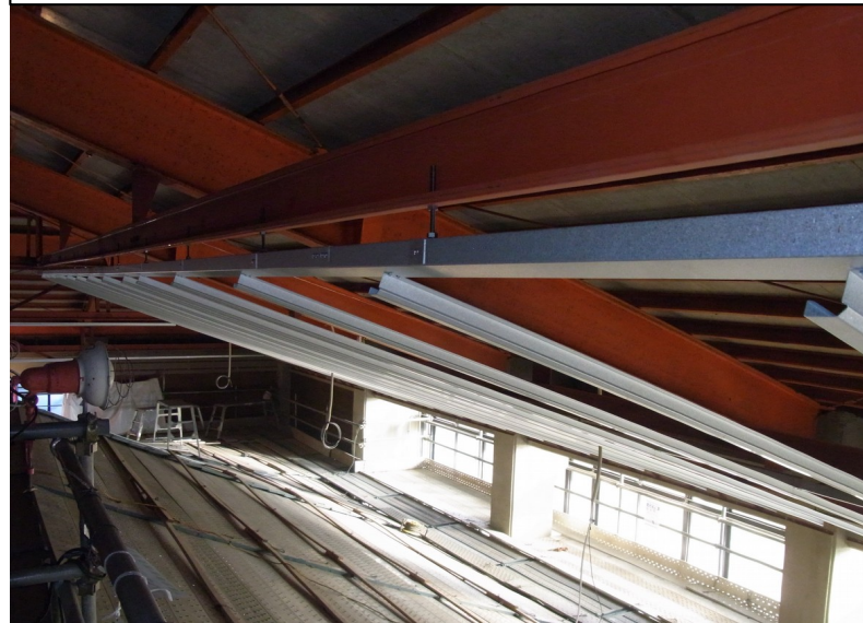
野縁受け(不陸調整)取付
