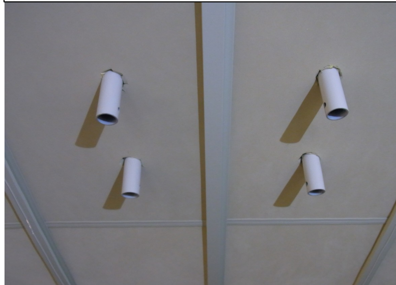
照明機器取付下地
