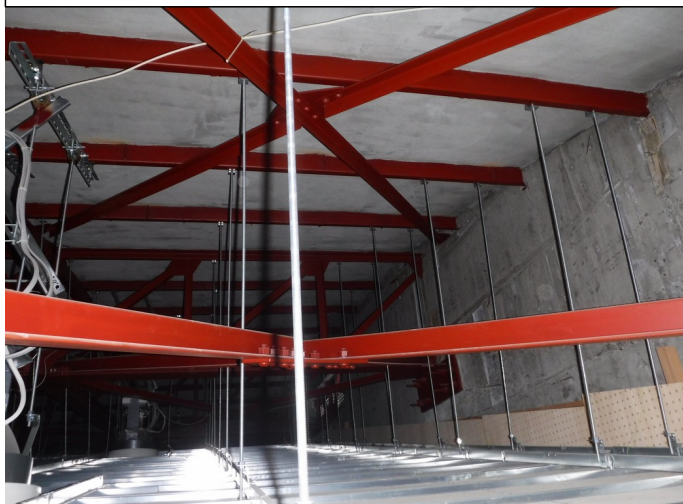
既存吊天井状況(撤去前)
