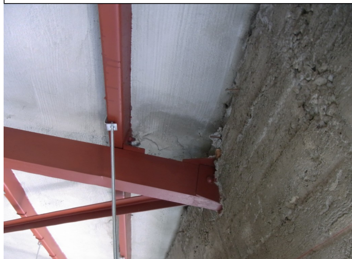
既存吊天井状況(撤去前)
