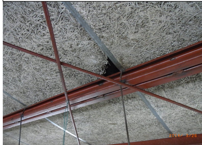
天井裏現況(施行前)
