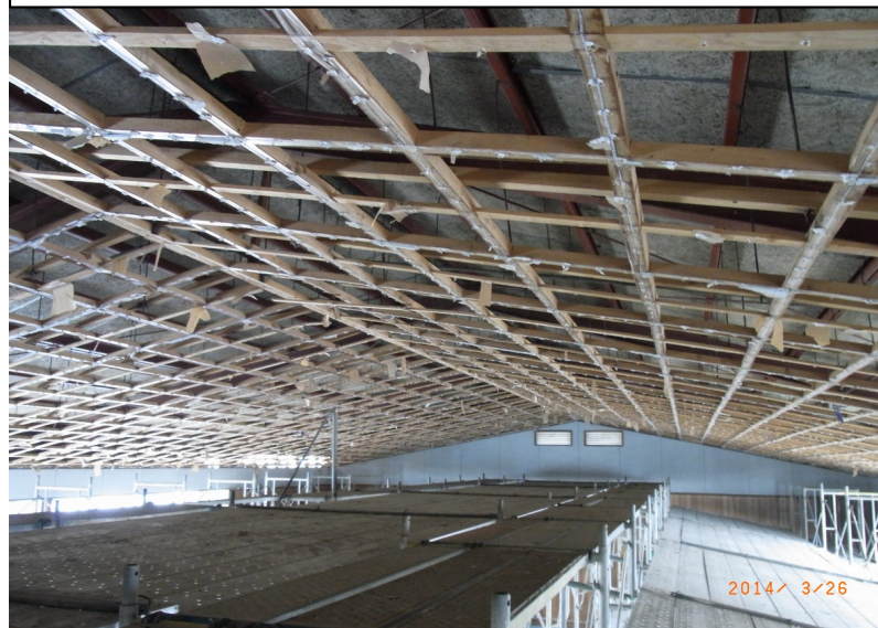
既存天井撤去
