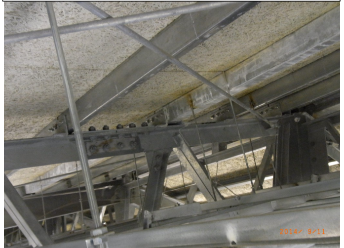
既存天井撤去後②
