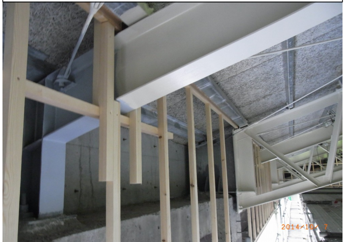
既存天井撤去後④
