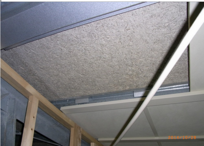
天井材取付け
