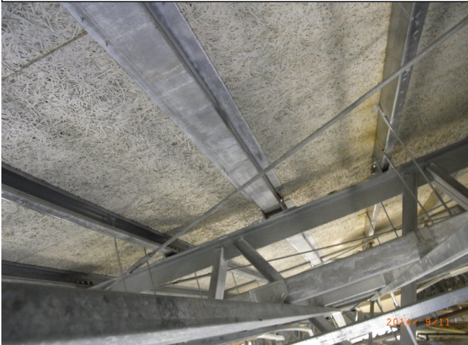
既存天井撤去後①
