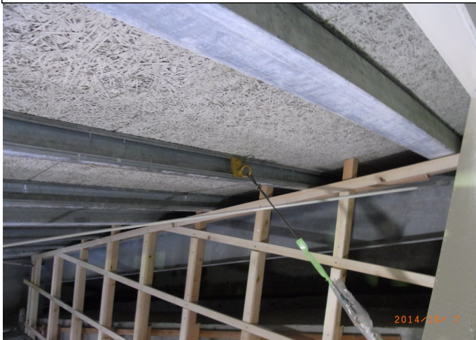
既存天井撤去後③
